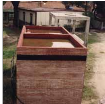
Vista superior de la caseta, con la cubierta inundada e impermeabilizada con espuma de poliuretano.
