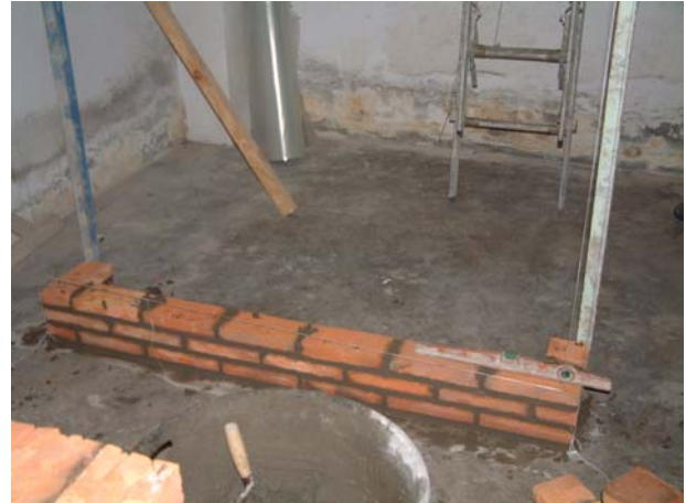
Foto 2: Construcción del muro soporte
