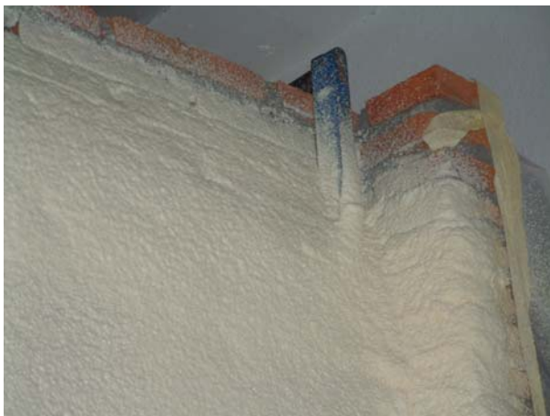
Foto 7:Detalle parte superior del murete
