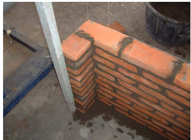
Foto 4: Construcción del muro soporte
