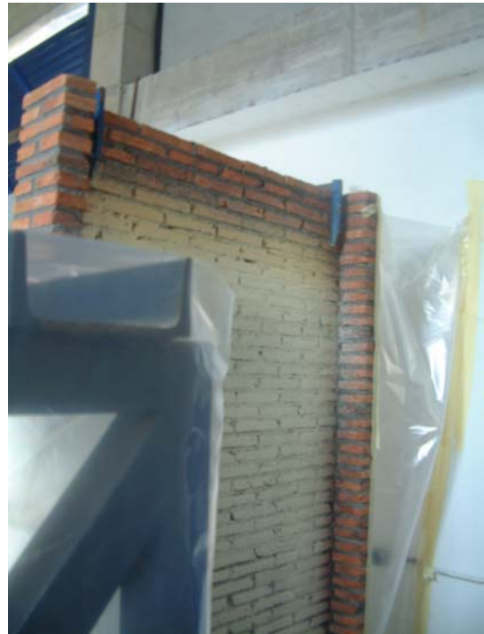
Foto 6: Aplicación del poliuretano
