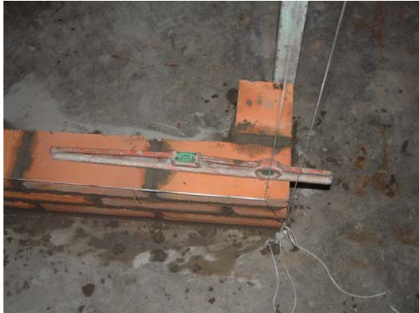
Foto 1: Construcción del muro soporte
