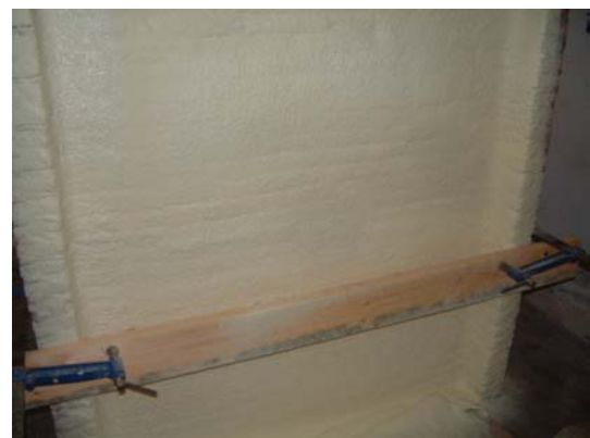
Foto 12: Zona inferior del murete durante el ensayo
