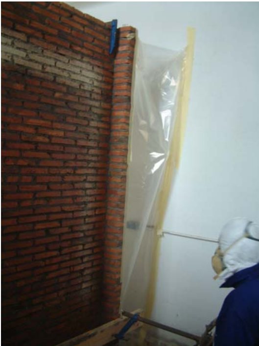
Foto 5: Aplicación del poliuretano
