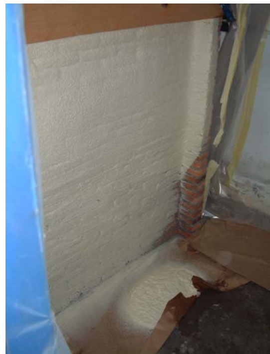
Foto 8: Detalle parte inferior del murete
