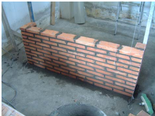
Foto 3: Construcción del muro soporte
